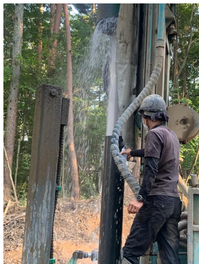
130m掘削して、水が噴出 井戸掘り成功！！
